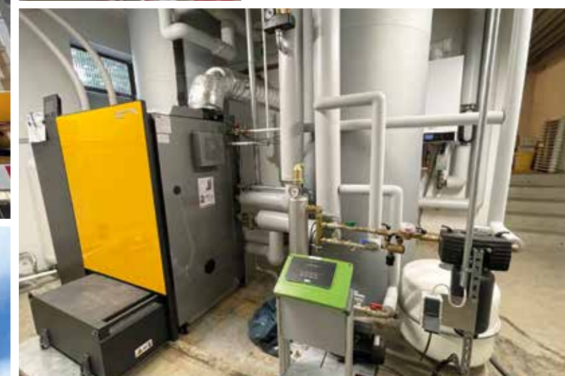
Fasanenstr. 20-26 | Erneuerung der Heizzentrale
