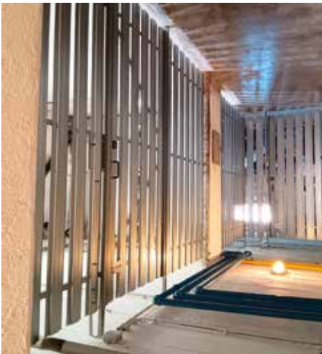
Kirmacherstraße 30 - 32 Sanierung Kellerabteile
