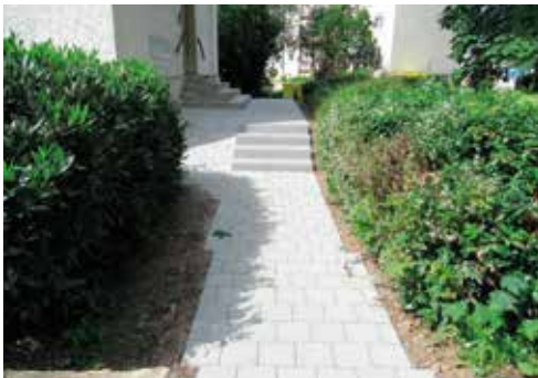
Martin-Luther-Straße 9 - 15 Erneuerung der Außenanlage
