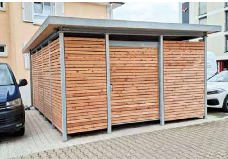
Von-Rechberg-Straße 6 - 8 Neubau Müllhaus
